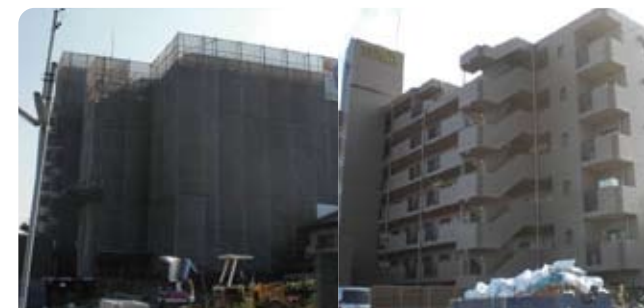
平成22年1月竣工 藤和シティコープ瀬戸水野
