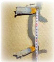
クラック補修 低圧注入工法
