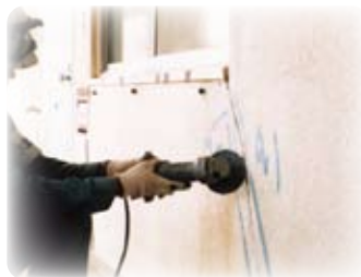
クラック補修 Uカット
