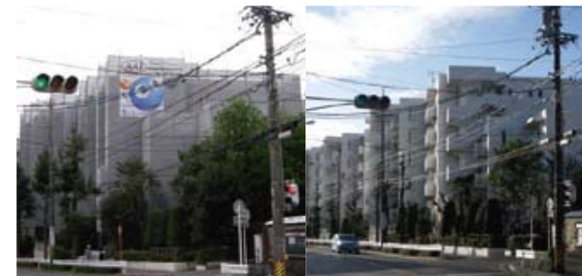
平成21年2月竣工 メゾン八事山
