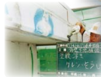
塗膜浮き ケレン・そうじ
