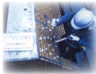
タイル浮き補修 アンカーピンニング工法
