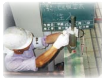
浮き・モルタル笠木注入
